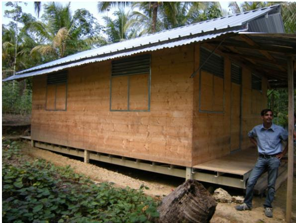
Verbesserungen der Konstruktion Eigeninitiative. Gut sichtbar ist auch die massive Stahlrahmen auf Pfosten, so daß das Gebäude nicht im Erdkontakt steht.
