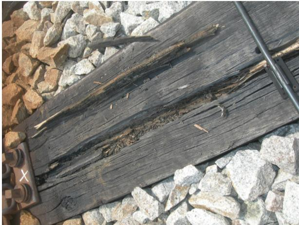
Schwellen zeigen nach 5 Jahren bereits massive Fäulnisschäden. Aufgefallen war das Problem durch Befestigungsschrauben, die sich im Betrieb gelöst hatten
