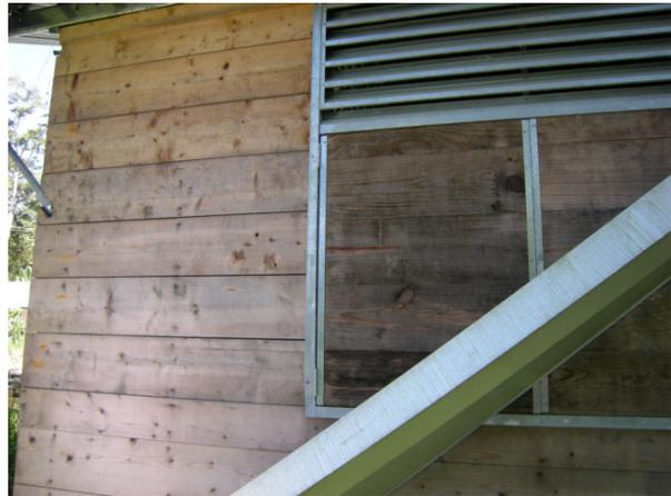
Detail: Unterschiedliche Intensität der Vergrauung. Die Wände bestehen aus Fichte, der Fensterladen dagegen aus Kiefer..
